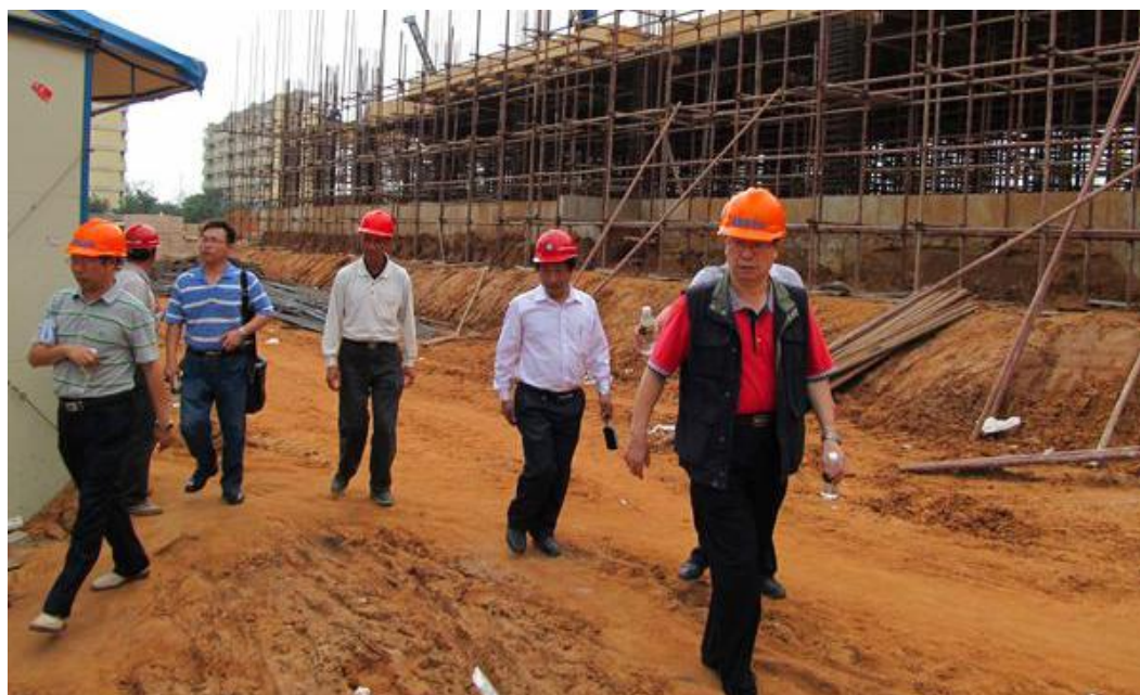
上图：曾渝副校长视察第四教学楼工地
