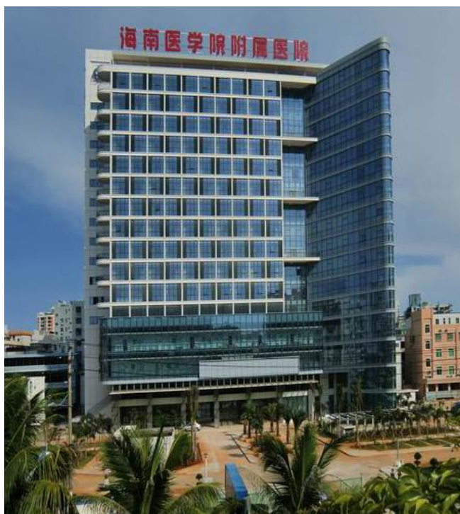
上图:新外科大楼
