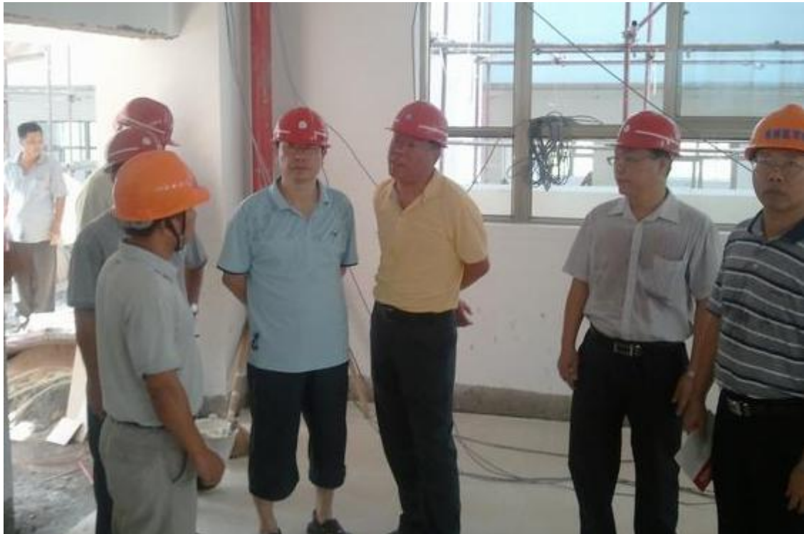
上图：吕传柱校长深入到第四教学楼在建项目工地实地调研
