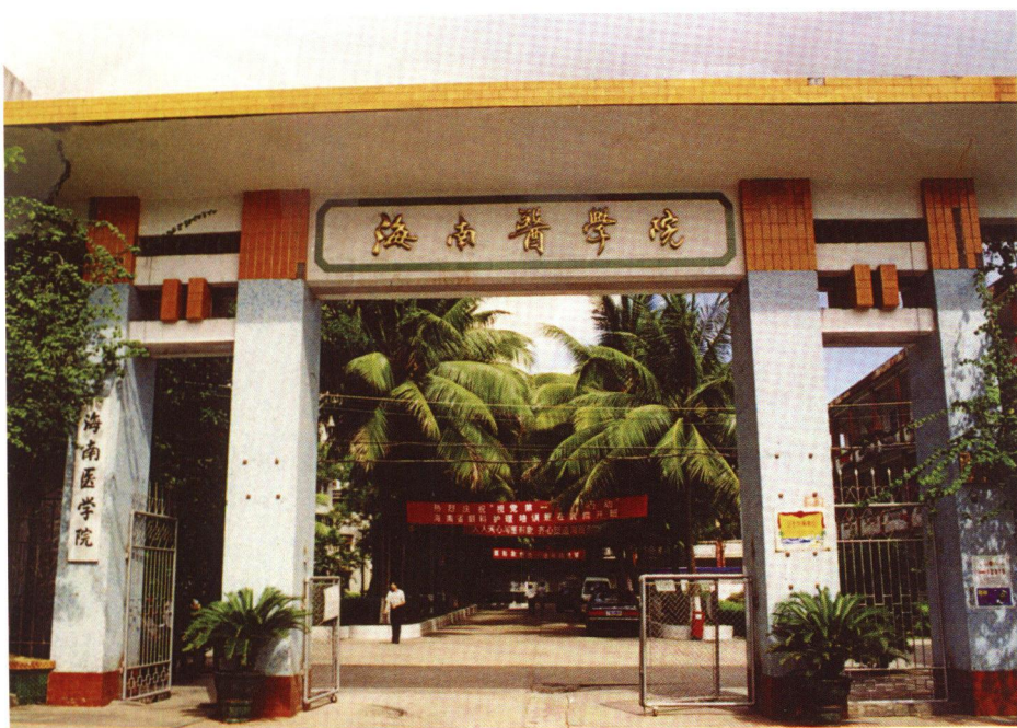
上图：龙华路33号学院旧校址大门，于2008年8月6日拆除
