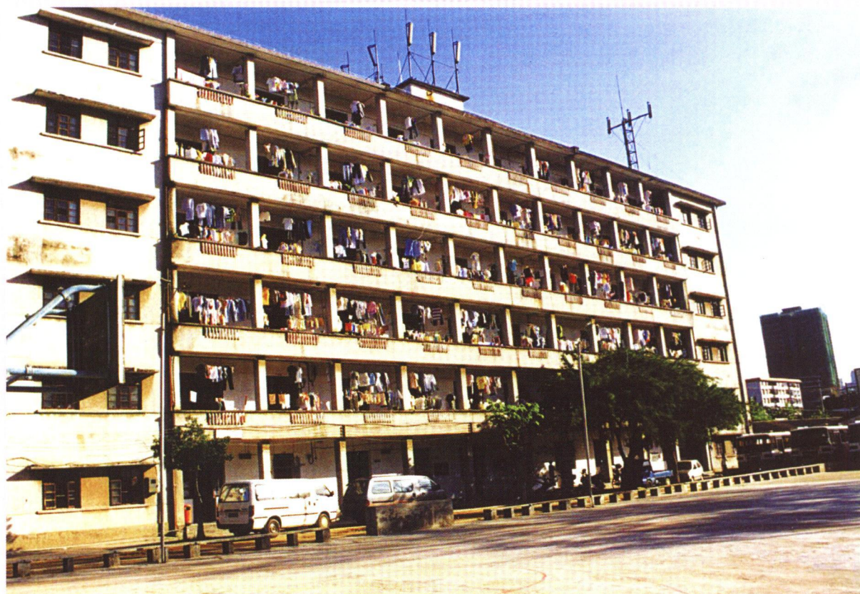
上图：旧校址学生宿舍楼于2008年4月8日动工拆除
