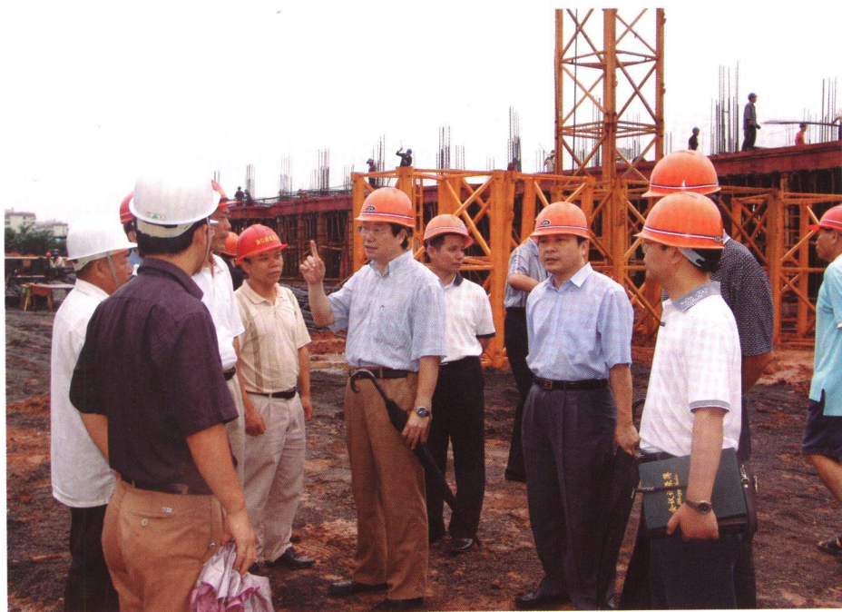
上图：学院副院长曾渝（中）视察南校区学生公寓楼工地
