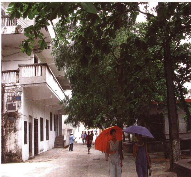
上图：旧校址电教楼，2007年10月15日拆除
