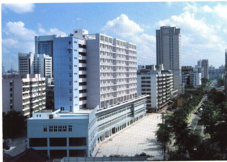
上图：学院新建成的学生公寓楼(中)，学生于2008年3月29日入住，8月11日学生公寓中的学生食堂启用
